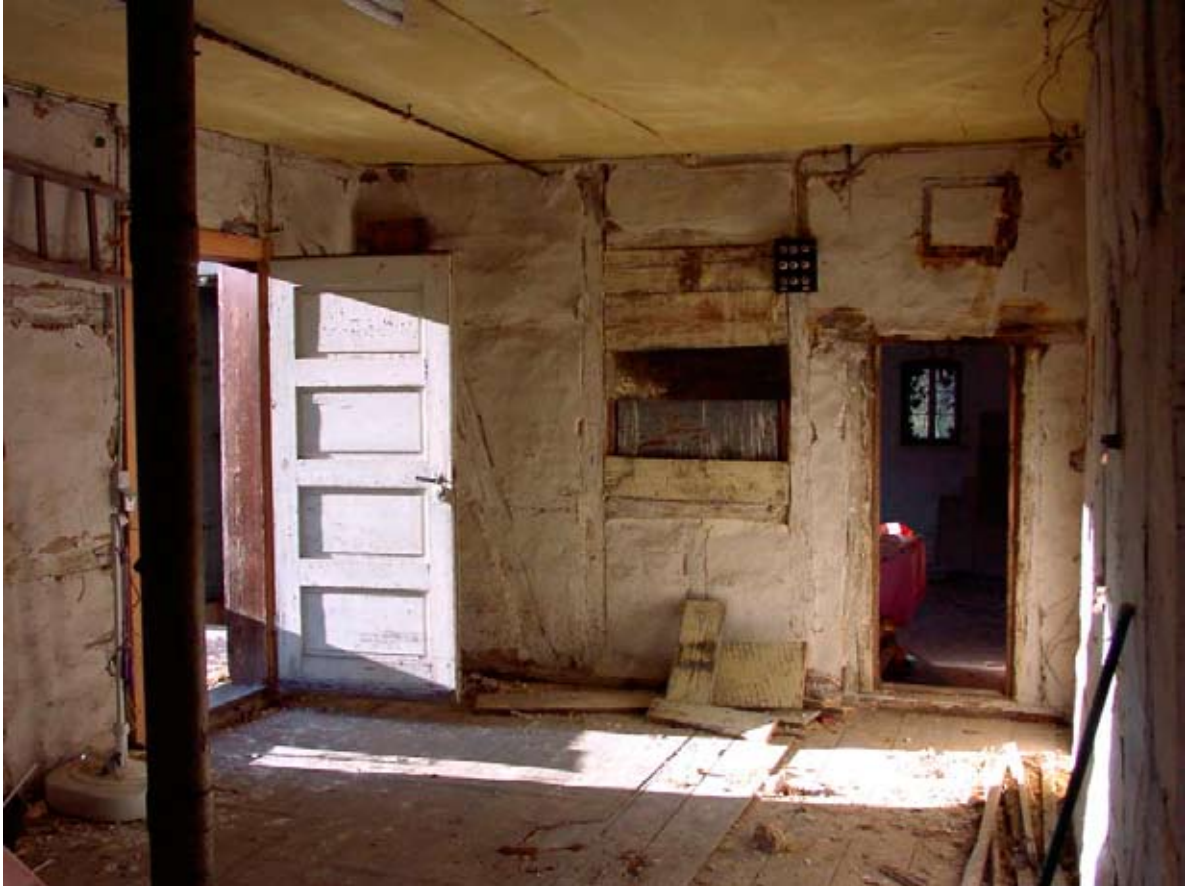
innenansicht der werkstatt bei der bestandsaufnahme
